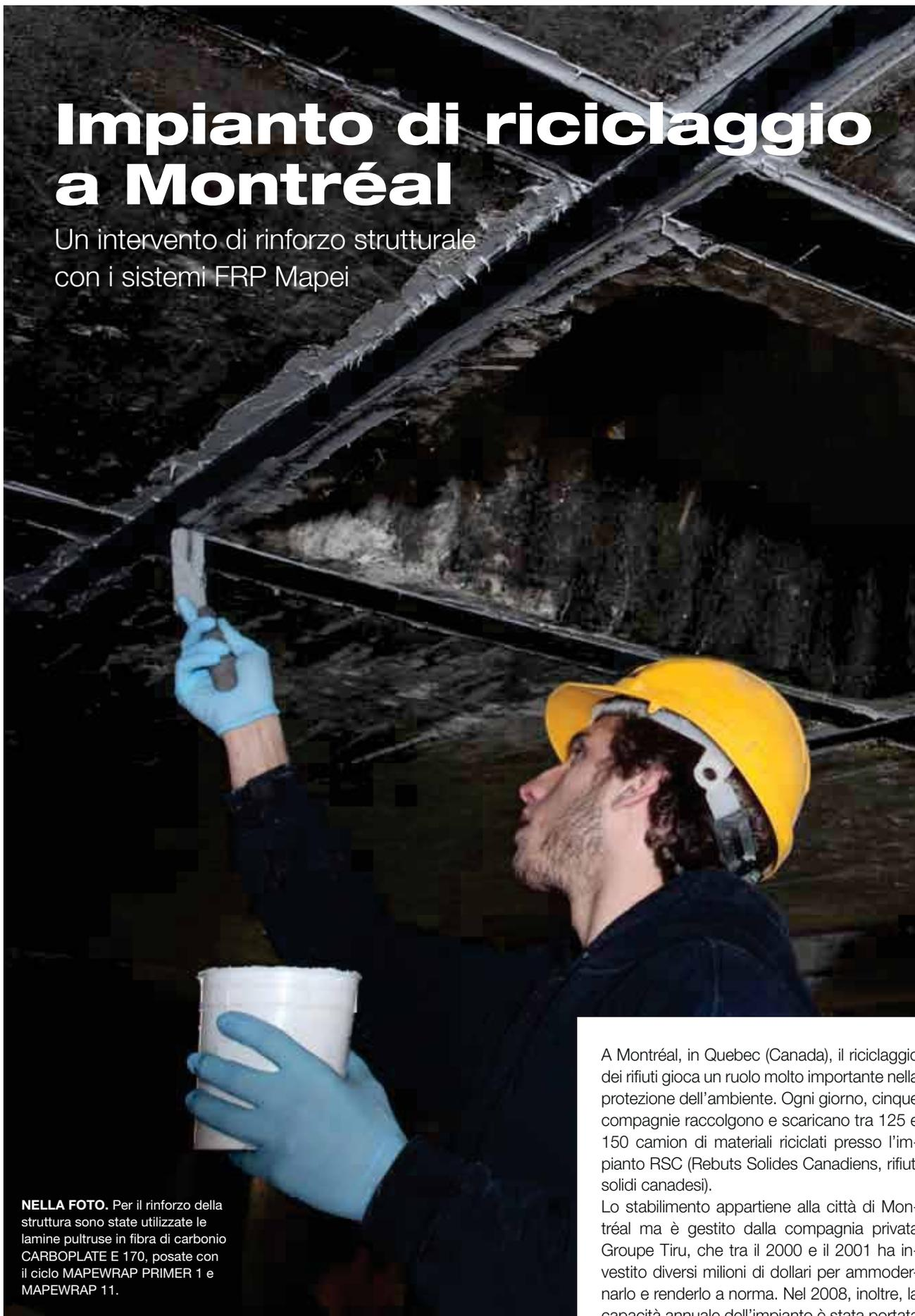
**NELLA FOTO.** Per il rinforzo della struttura sono state utilizzate le lamine pultruse in fibra di carbonio CARBOPLATE E 170, posate con il ciclo MAPEWRAP PRIMER 1 e MAPEWRAP 11.
