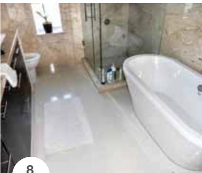
**FOTO 6, 7 e 8.** La superficie è stata trattata con PRIMER E e cosparsa di sabbia, prima di applicare ULTRATOP WHITE sui i pavimenti di cucina, sala, corridoi, bagni e camere da letto.
