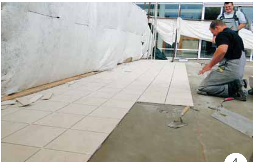
FOTO 4. La posa delle piastrelle in gres porcellanato, eseguita con l'adesivo cementizio KERAFLEX MAXI S1.
