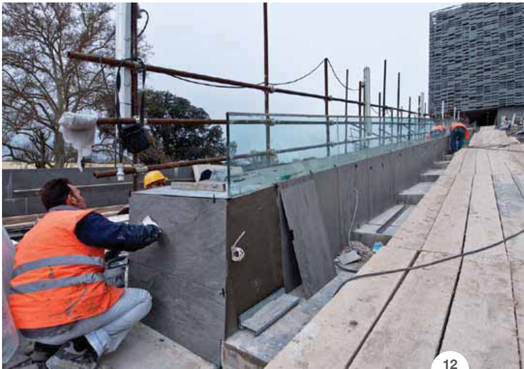
FOTO 11. Posizionamento delle lastre Kerlite.
