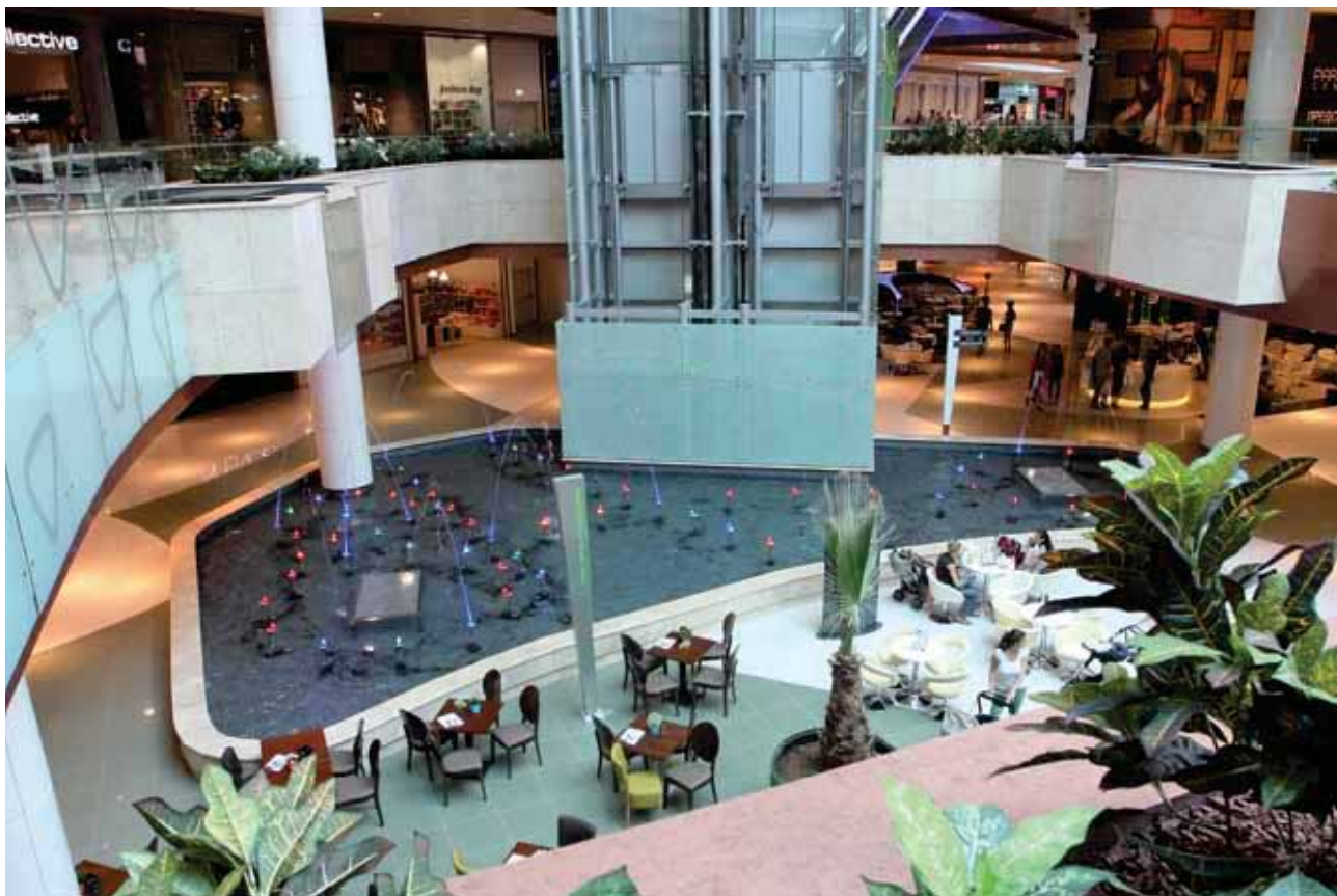
SOPRA. La fontana del centro commerciale è stata impermeabilizzata con MAPELASTIC.
