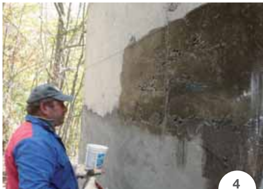
FOTO 4. L'applicazione del primer epossidico MAPEWRAP PRIMER 1.
