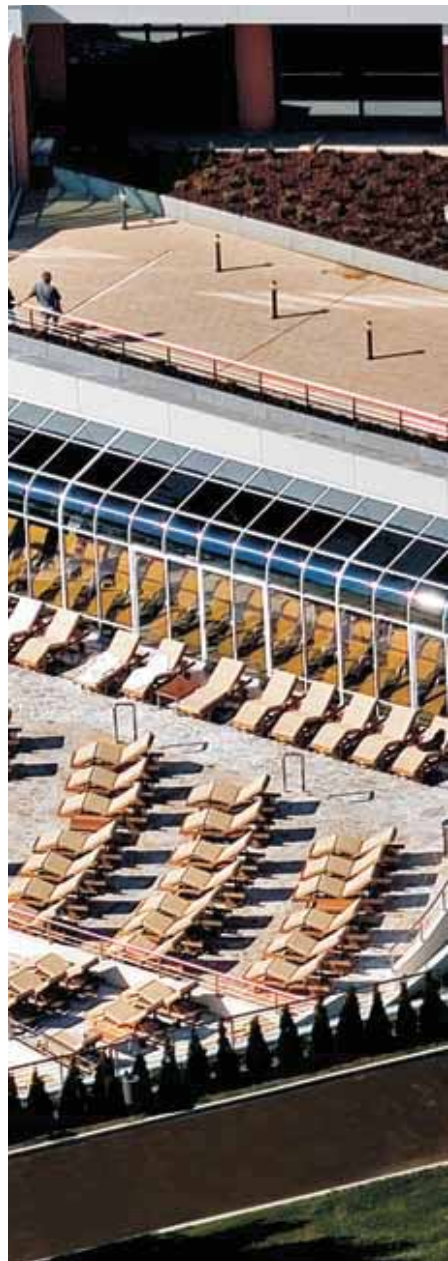
FOTO 1. La regolazione del supporto della terrazza con la malta cementizia PLANITOP FAST 330.
