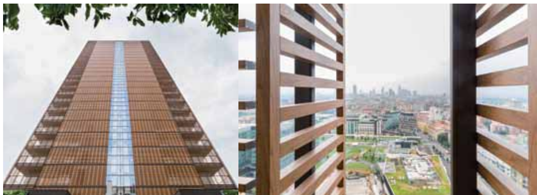
Un'immagine della Giax Tower. L'edificio è dotato di frangisole a lamelle orizzontali, movimentati elettricamente.
