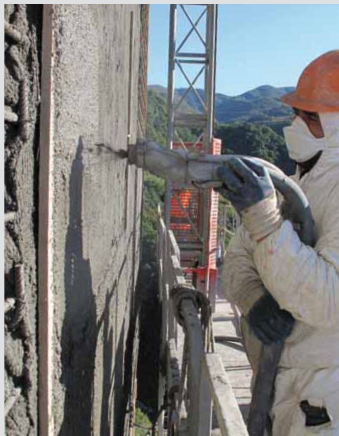
SOPRA. Applicazione a spruzzo di MAPEGROUT EASY FLOW, malta monocomponente cementizia tissotropica fibrinforzata, a ritiro compensato e resistente ai solfati. Questo prodotto risponde ai principi definiti nella EN 1504-9 e ai requisiti minimi richiesti dalla EN 1504-3 per le malte strutturali di classe R4.
