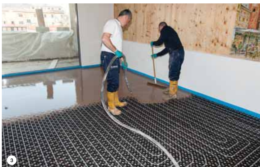
FOTO 3. Riempimento dell'impianto e livellamento con NOVOPLAN MAXI.
