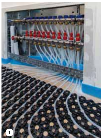
FOTO 1. Un sistema ribassato con pannello in plastica autoadesivo preformato dello spessore di 18 mm.
