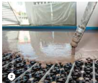
FOTO 1. Un sistema ribassato con pannello in plastica autoadesivo preformato dello spessore di 18 mm.
