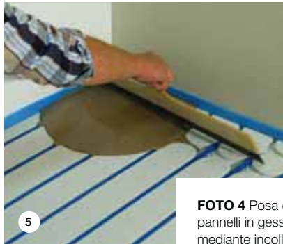
FOTO 5. Riempimento delle fresature e livellamento del pannello in gesso fibra con NOVOPLAN MAXI.
