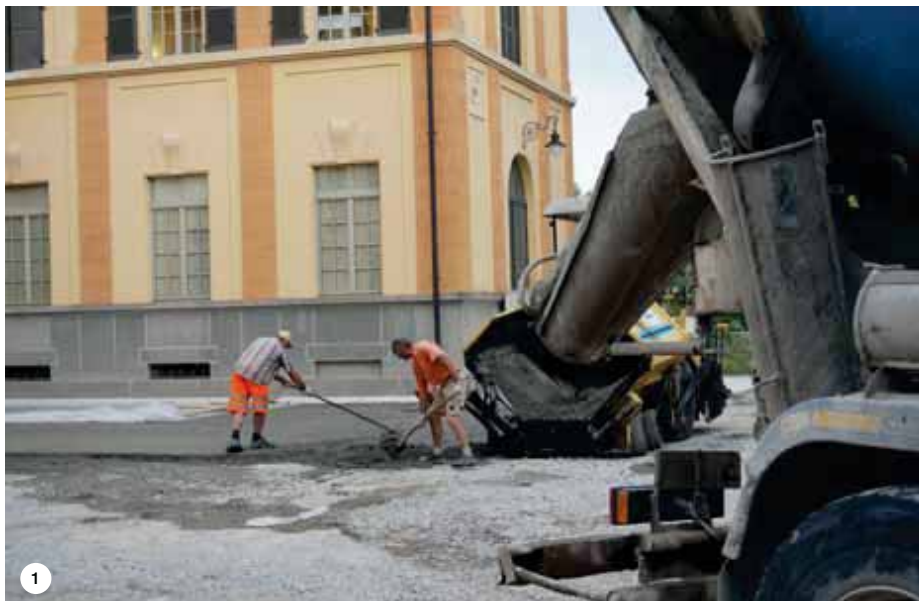
FOTO 1. Scarico diretto del calcestruzzo drenante consegnato sfuso in autobetoniera. FOTO 2. La posa è stata effettuata con l'aiuto di una vibrofinitrice stradale. FOTO 3. La compattazione dopo la posa è stata effettuata con il rullo a mano. FOTO 4. L'intervento è terminato con la stagionatura coprendo il supporto con teli di plastica. FOTO 5. Un particolare della pavimentazione.
