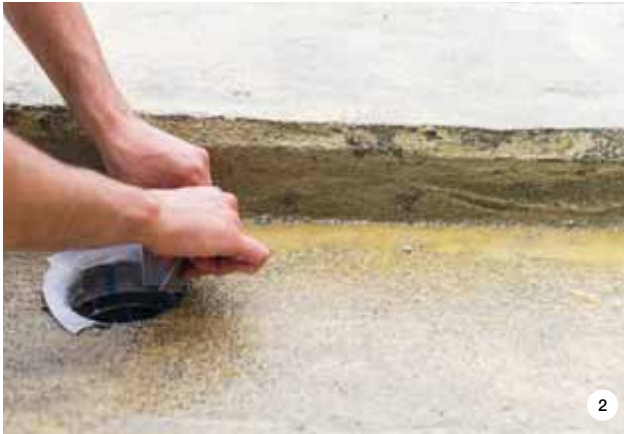
FOTO 1. La grande terrazza esterna prima dell'impermeabilizzazione è stata trattata con PRIMER SN. FOTO 2. Gli scarichi sono stati sigillati con MAPEBAND SA. FOTO 3. La terrazza esterna al piano terra della villa è stata impermeabilizzata con PURTOP 1000. FOTO 4. Il rinforzo strutturale della
