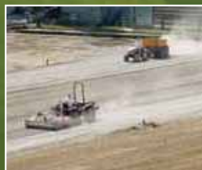
STABILIZZAZIONE CON Mapesoil 50
