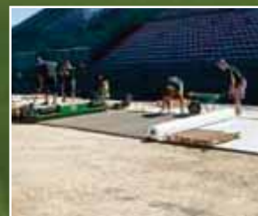
CONFEZIONAMENTO E STESA DELLA MISCELA DRENANTE CON Mapesoil VD
