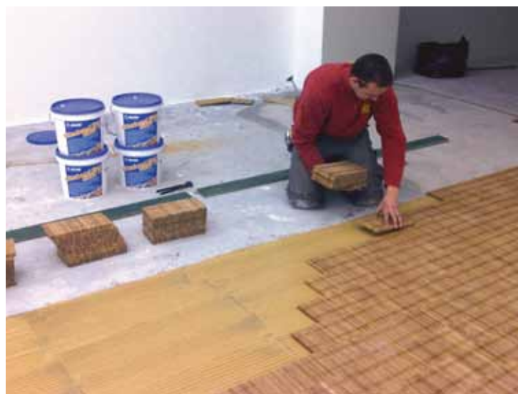
SOPRA. Prima della posa, sulla superficie è stato applicato PRIMER G. SOTTO. Dopo la rasatura con MAPESOL 3, posa del parquet è stata effettuata con l'adesivo ULTRABOND ECO S 955 1K.
