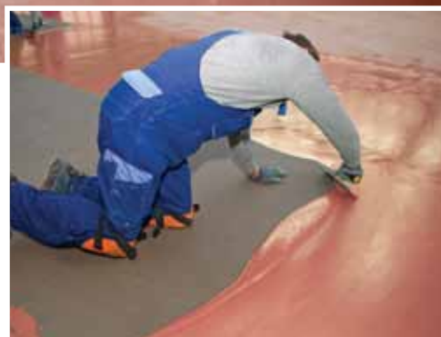
APPLICAZIONE A SPATOLA CON Mapefloor I 300 SL
