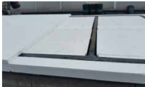
POSA ISOLANTE TERMICO IN EPS
