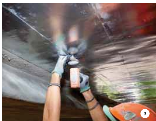
FOTO 3. È stato eseguito un ancoraggio supplementare con tasselli plastici.
