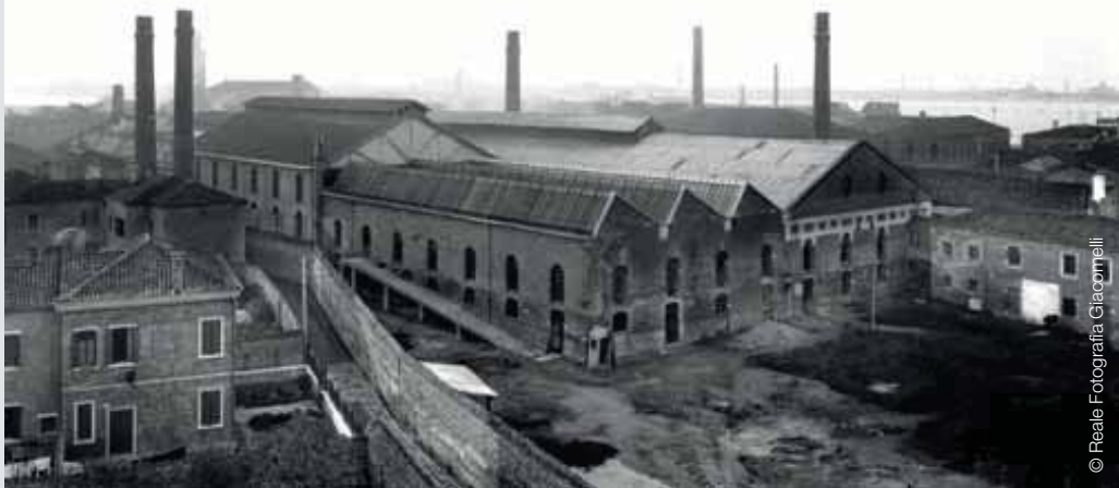
SOPRA. Il complesso delle Conterie in un'immagine d'epoca (Comune di Venezia-Archivio della Comunicazione).
