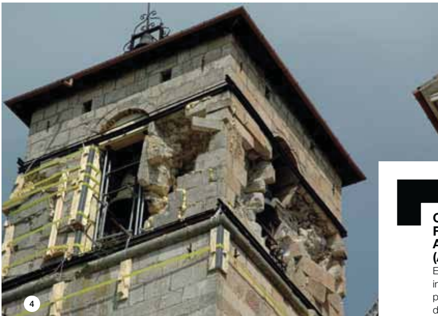
FOTO 4. I lavori sul campanile pericolante della chiesa di San Felice Martire sono stati effettuati da squadre di soccorso S.A.F. dei Vigili del Fuoco.
