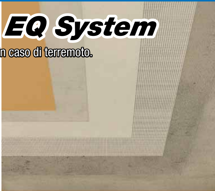
SOLAIO PRESIDATO CON MapeWrap EQ System
