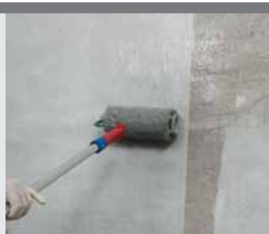
SOPRA. Applicazione del 2° strato di MAPEWRAP EQ ADHESIVE.
