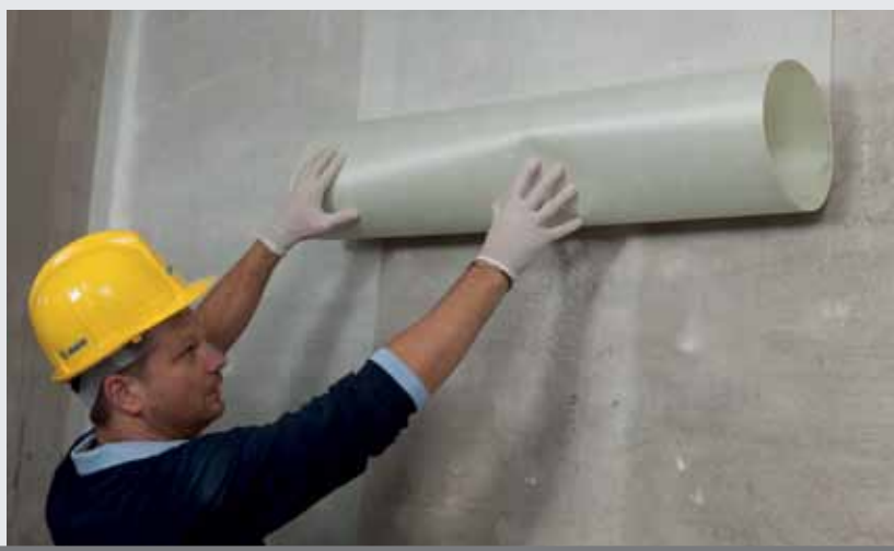
SOTTO. Applicazione di MAPEWRAP EQ NET (risolto in orizzontale e sovrapposizioni laterali di almeno 10 cm).
