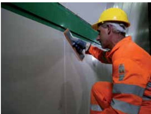
IN QUESTE FOTO. La posa delle piastrelle di grande formato è avvenuta con KERAFLEX MAXI S1
