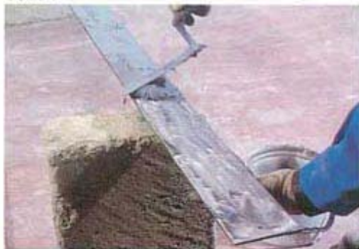
FOTO 4 Applicazione di ADESILEX PG1 sulla placca metallica
