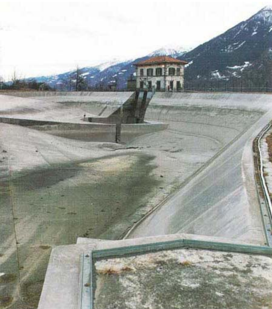
A lato: ripristino della zona paratoie e dell'imbocco alle condotte forzate. La foto in alto mostra il lavoro ultimato
