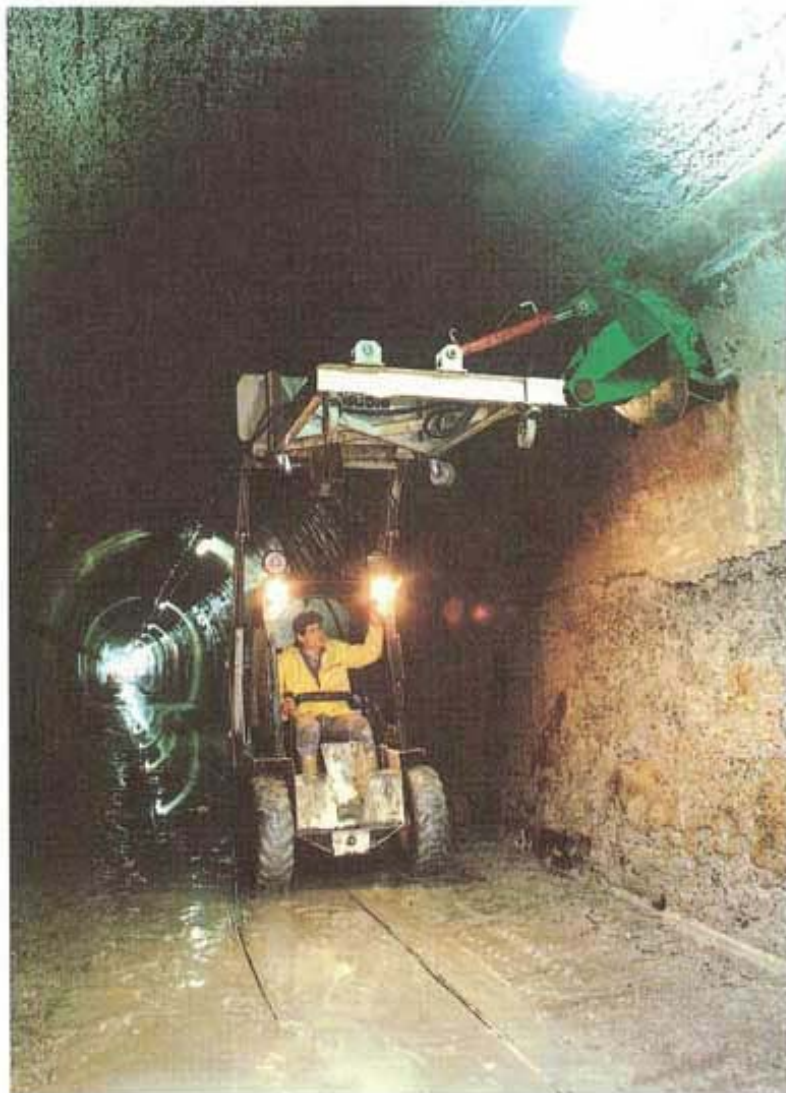
Sopra, idroscarifica di galleria di derivazione a Boffetto, Sondrio (Committente: Enel)
