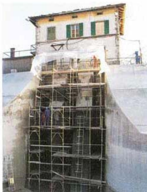
A lato: ripristino della zona paratoie e dell'imbocco alle condotte forzate. La foto in alto mostra il lavoro ultimato
