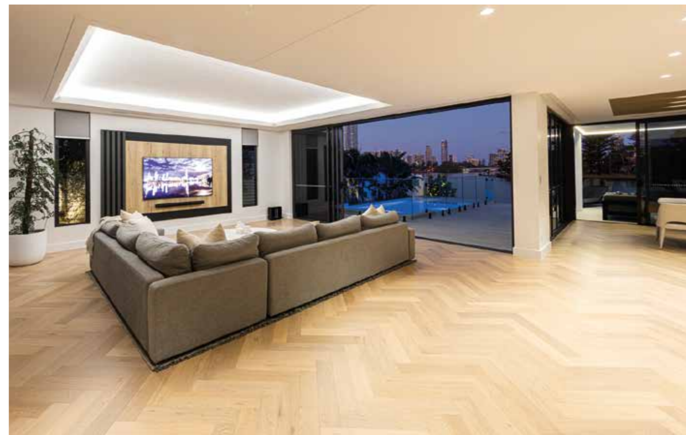
IN ALTO. Al piano terra il parquet è stato posato a liscia di pesce con un sistema completo che ha previsto il trattamento dei sottofondi con ECO PRIM T PLUS e ULTRAPLAN ECO e l'incollaggio dei rivestimenti in legno con ULTRABOND ECO S955 1K.
