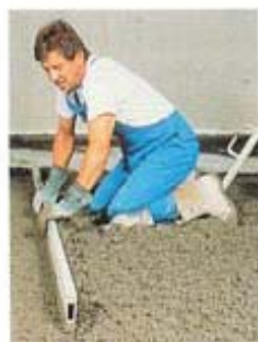
FOTO 1 Formazione di un massetto in Mapecem
