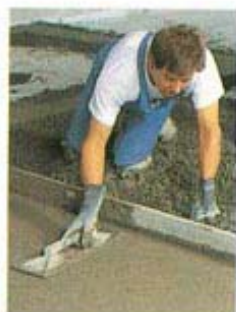
FOTO 5 Finitura con frattazzo di un massetto
