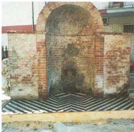
Il primo intervento degli allievi del corso "Posatori Marmo e Muratori in genere" della Scuola Edile di Massa Carrara, ha riportato agli antichi splendori una fontana nella zona periferica di Carrara
