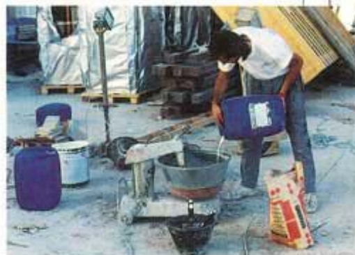
Miscelazione di Kerabond e Isolastic
