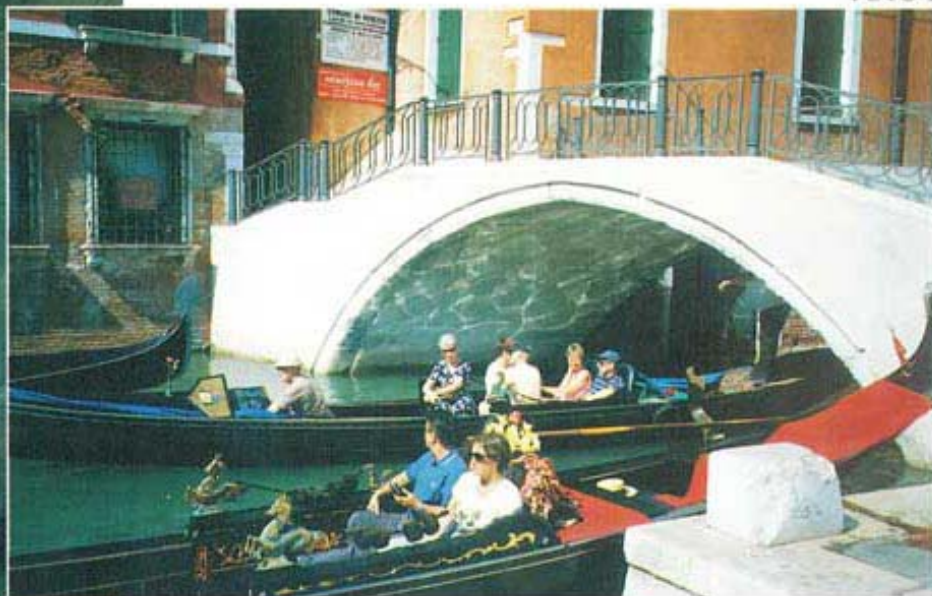
Foto 3 e 4 Un particolare e una veduta del ponte ristrutturato
