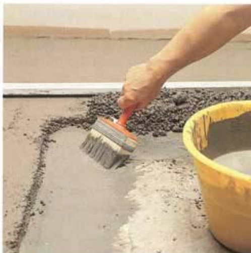
Stesura boiaccia di ancoraggio per massetti in Mapecem aderenti
