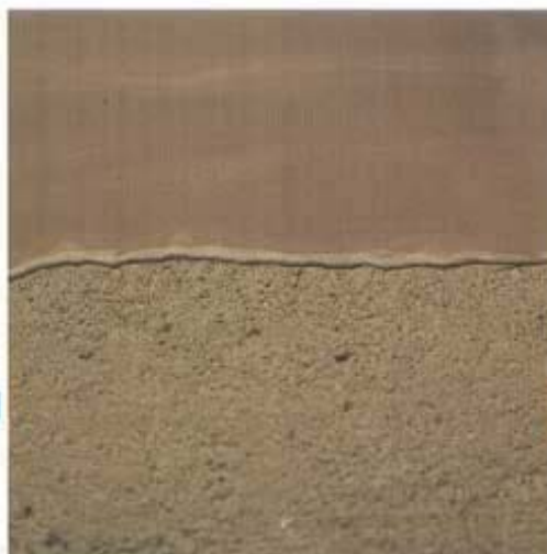
Finitura di massetto in Mapecem con Ultraplan autolivellante
