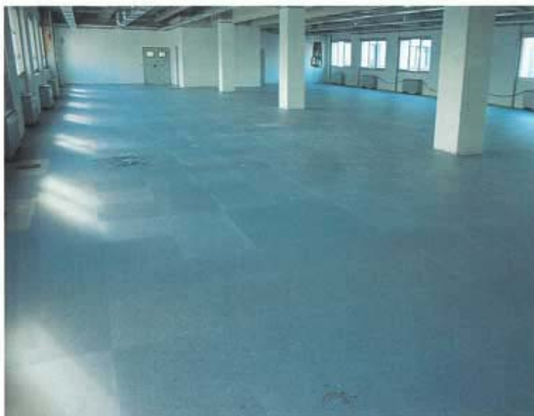
Posa di pavimenti in pvc su massetto in Mapecem e, sotto, come si presenta il locale finito
