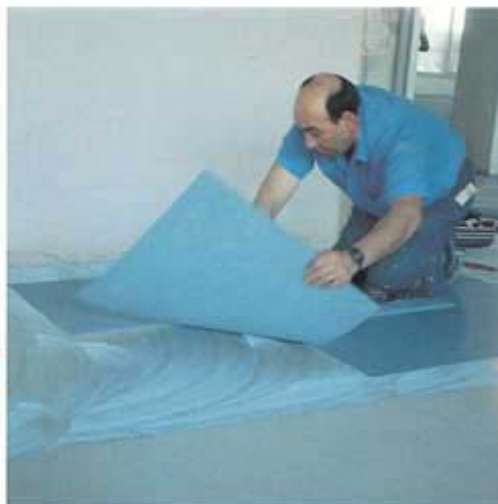
Posa di pavimenti in pvc su massetto in Mapecem e, sotto, come si presenta il locale finito
