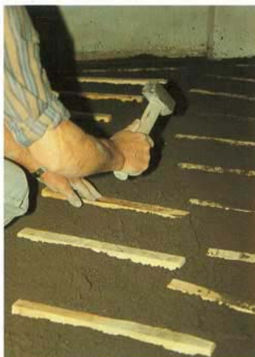
Posa di parquet inchiodato: i magatelli vengono annegati nel massetto di Mapecem.
