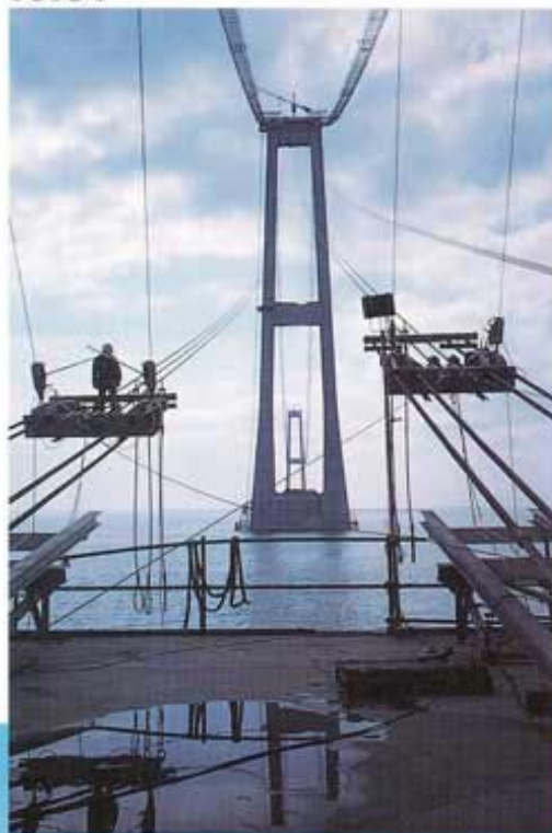
Foto 1 "The Great Belt Link", con due ponti (West Bridge e East Bridge) sospesi fra le isole della Danimarca e un tunnel sottomarino fra il Mare del Nord e il Mar Baltico permetterà il collegamento permanente con l'Europa continentale
