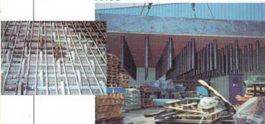
Foto 2 Particolari del cassero utilizzato per il "full scale test" per il getto degli inghisaggi con l'apparecchio d'appoggio e la parte terminale della pila riprodotta nello stabilimento Mapei di Mediglia
