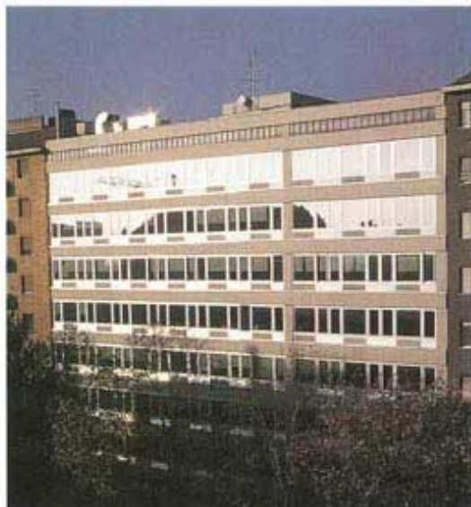
Sede degli uffici commerciali, amministrativi, marketing e assistenza tecnica - Mapei SpA Milano - Viale Jenner 4
