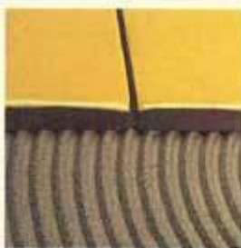
Sotto, oltre 30.000 metri quadri in lastre di granito, con spessore di 7 mm, posati su massetti in MAPECEM con KERALASTIC. Le fughe sono state riempite con ULTRACOLOR
