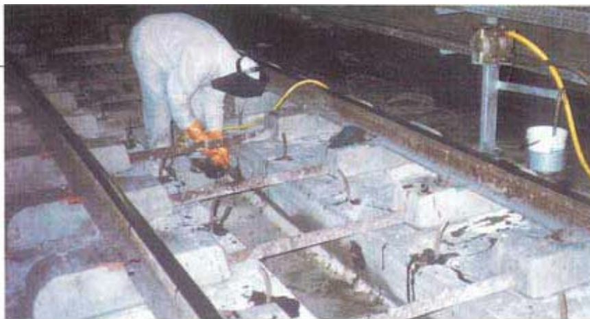
Risanamento strutturale linea "B" metropolitana tratto Eur Fermi-Laurentina. Roma
