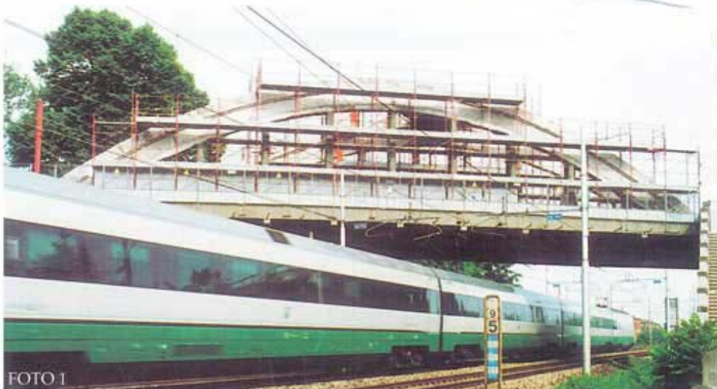
Foto 1 Vista del cantiere
