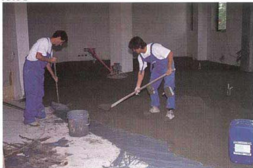
Preparazione del massetto: nuova sede della Colnago, Cambiago (MI)
