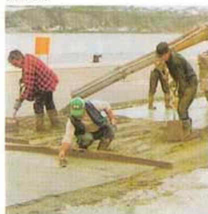
Pavimento esterno in calcestruzzo modificato con PLANICRETE. Cantiere Vieux Port, Quebec, Quebec, Canada
