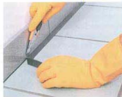
Installazione del battiscopa: piegare MAPEFONIC STRIP sulla superficie del pavimento; rimuovere la parte in eccesso di MAPEFONIC STRIP con taglierino
