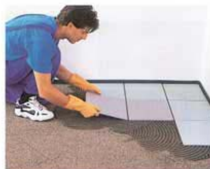
Posa di piastrelle su MAPEFONIC MORTAR
