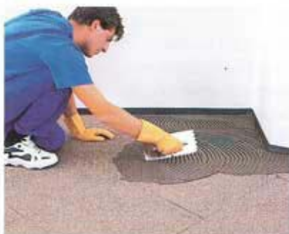
Stesura di MAPEFONIC MORTAR su MAPEFONIC PAD
