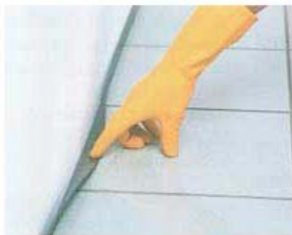
Installazione del battiscopa: piegare MAPEFONIC STRIP sulla superficie del pavimento; rimuovere la parte in eccesso di MAPEFONIC STRIP con taglierino
