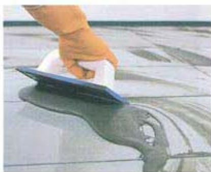
Stuccatura delle fughe con MAPEFONIC GROUT
