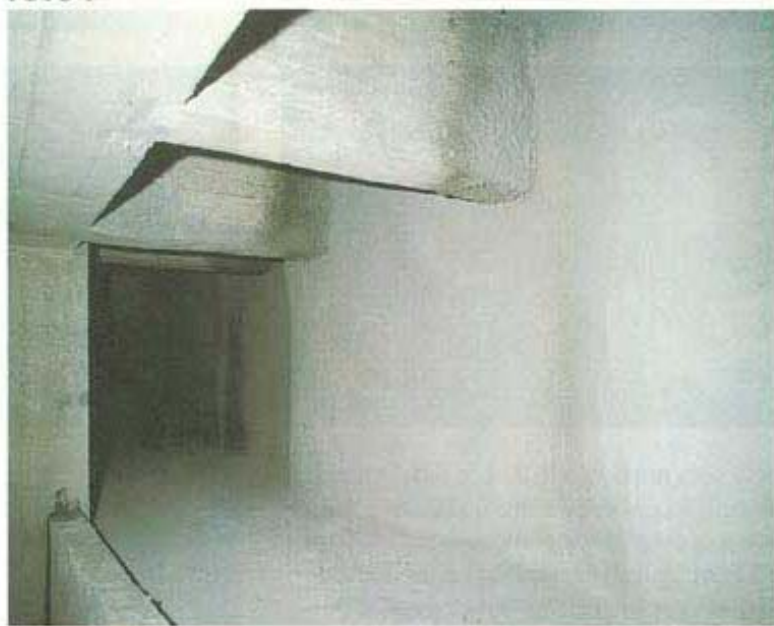
Foto 4 Come si presenta la paratia ad impermeabilizzazione avvenuta
