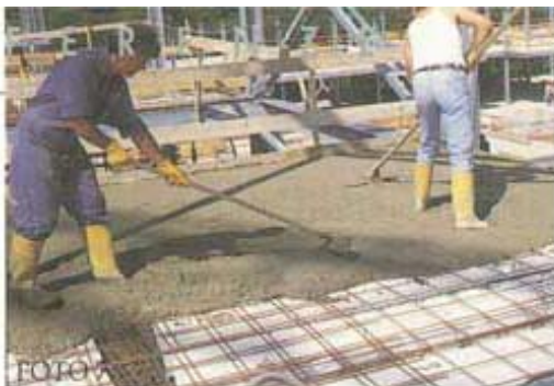
Foto 7 La superficie del getto viene regolarizzata con un'operazione manuale
