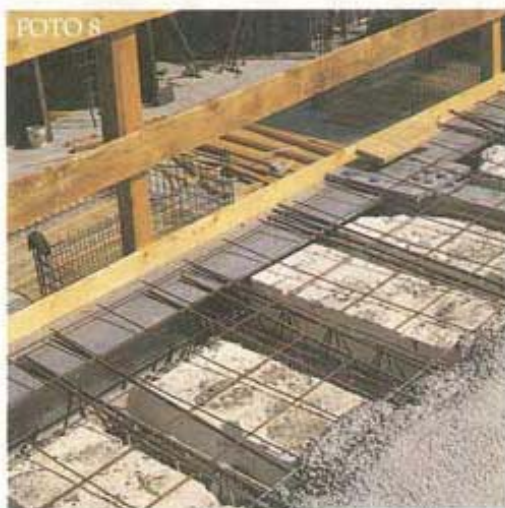
Foto 8 Un dettaglio del sistema finale costituito da pilastri, travi, predalle, rete e getto di cls
