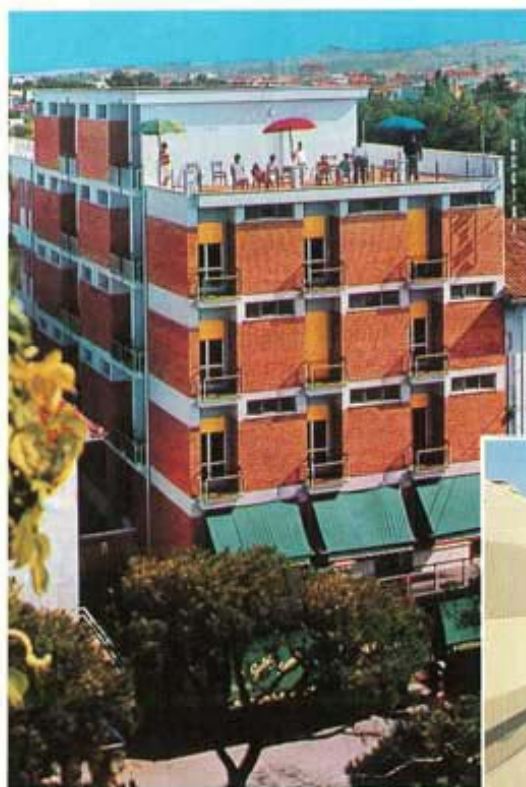
L'edificio prima dell'intervento era caratterizzato da mattone faccia a vista.
