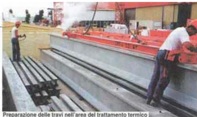
Preparazione delle travi nell'area del trattamento termico
