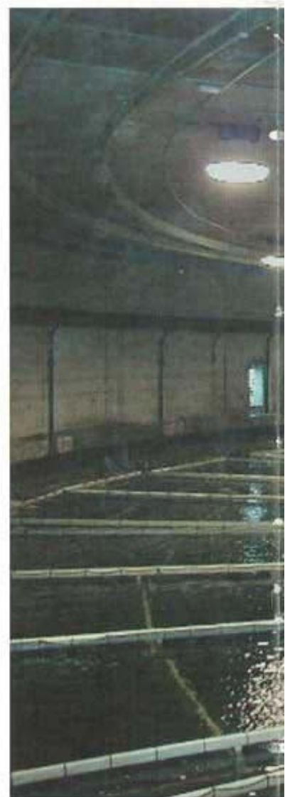
6. Cisterna degli avannotti rivestita con MAPELASTIC (prima della pulitura finale)
