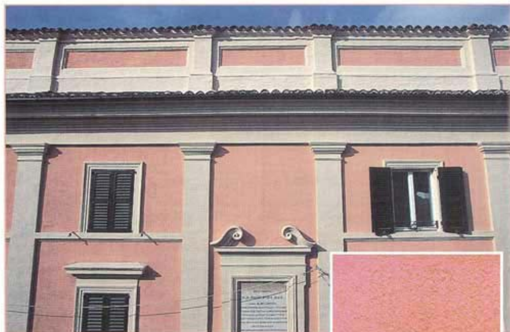
Collegio Gentile, Fabriano (AN). Nel particolare si evidenzia la grana di SILEXCOLOR TONACHINO utilizzato per la finitura
