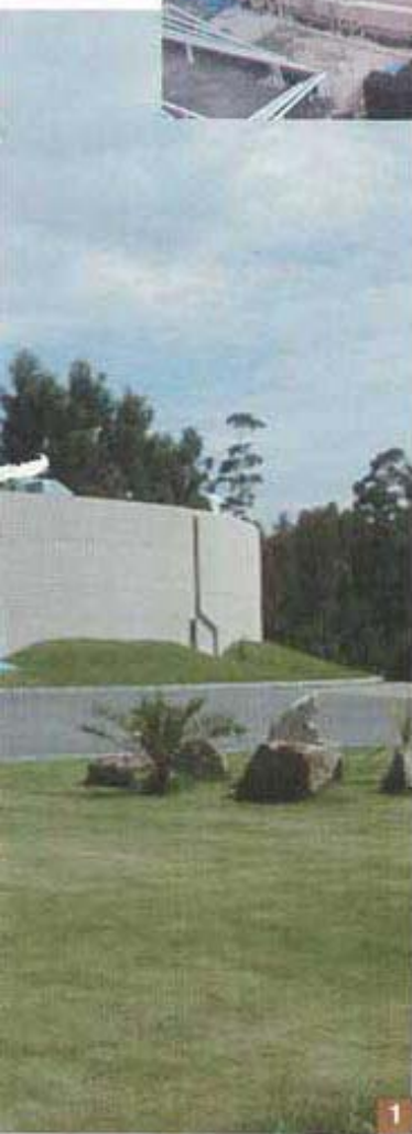
1. Panoramica esterna del serbatoio con sistema di alimentazione e ventilazione
