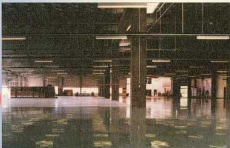
Dancall Telecom - pavimentazione antistatica
