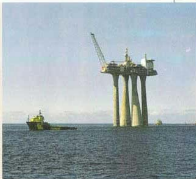
Piattaforma Petrolifera in cemento "Troll"
