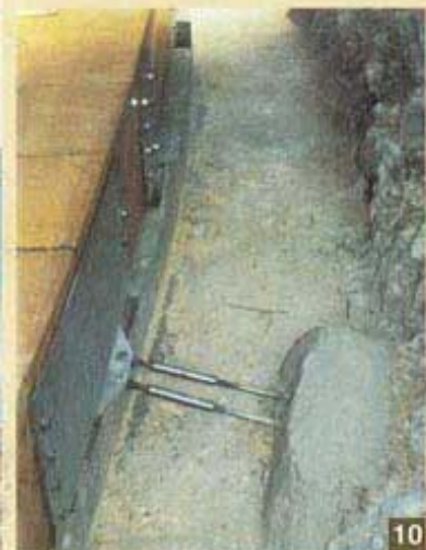
Foto 10 - I tiranti in acciaio inox della trave di bordo della pedana sono stati ancorati con Mapefill sul cordolo esterno
