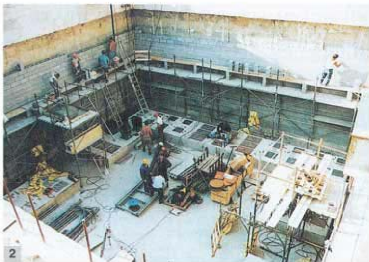
Foto 1 - Scavo del sito entro il quale sarà alloggiata la massa sismica
