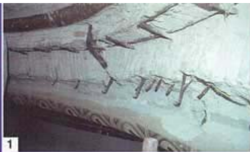
Foto 1. Demolizione della centina tra cupola e lanterna
