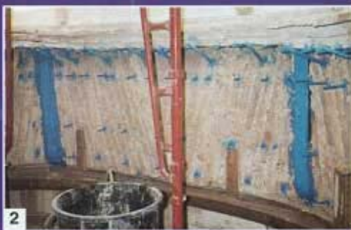
Foto 3. Ancoraggio della malta MAPE-ANTIQUE MC con rete porta intonaco zincata
