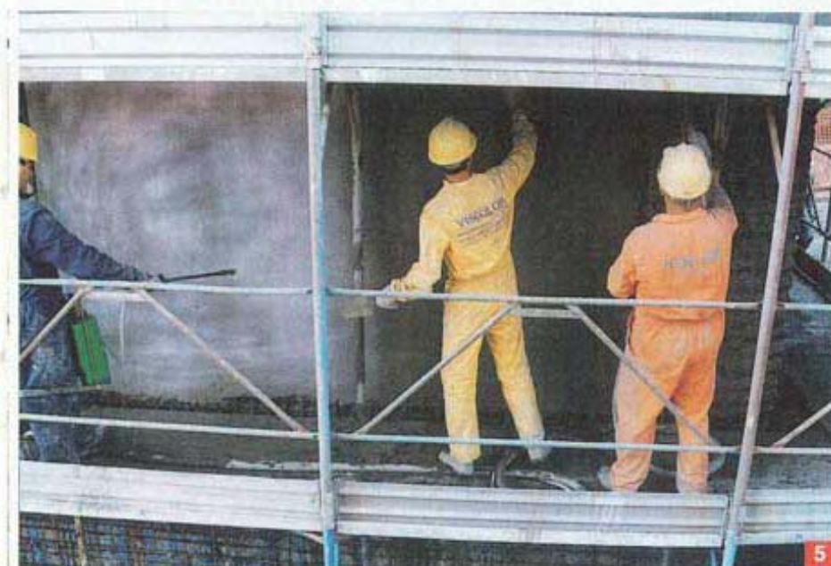
Foto 1. Particolare del calcestruzzo ammalorato
