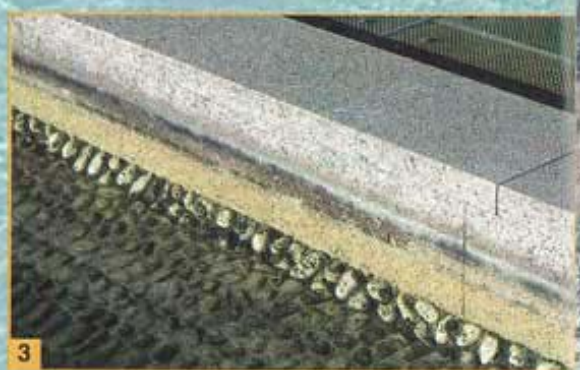
Foto 1 e 2 Stesura del GRANIRAPID® e posa delle lastre di granito Foto 3 Particolare del bordo vasca dopo la posa del rivestimento
