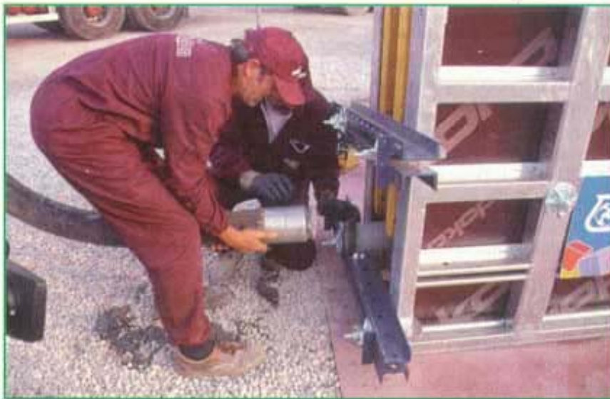
Fig. 7. Realizzazione di un muro di sostegno con getto di calcestruzzo autocompattante effettuato dal basso.
