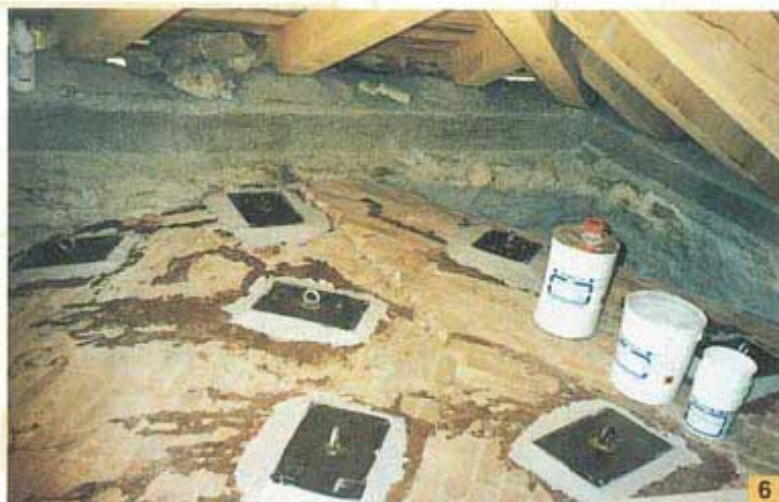
Foto 8. Il sistema tiranti/cavi/piastre in esercizio a intervento ultimato.
