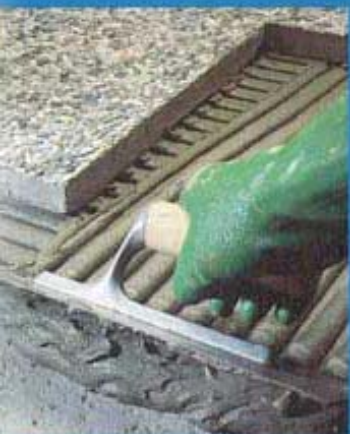
Posa di marmette con graniglie in rilievo all'esterno
