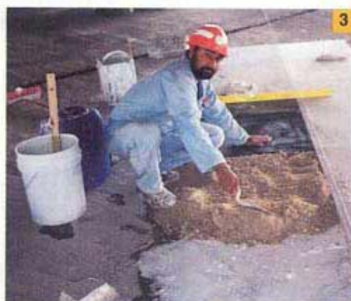
Foto 3 e 4. La posa del granito è stata effettuata con malta cementizia, utilizzando PLANICRETE.
