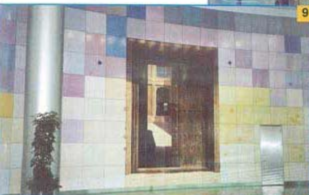
Foto 9. Particolare dei corridoi d'accesso alle lounges e all'hotel: sono state utilizzate piastrelle in ceramica di grande formato (60x60), posate con KERACRETE.
