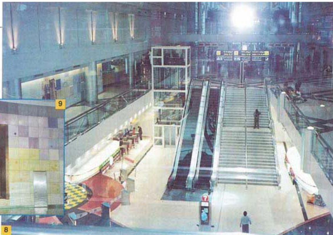
Foto 8. Le scale di collegamento sono state rivestite in granito utilizzando KERALASTIC.
