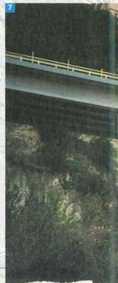
Foto 6. Per evitare il riaffiorarsi di fenomeni di degrado dovuti al percolamento delle acque meteoriche dall'impalcato, sono stati realizzati due canali di regimentazione in grado di raccogliere e convogliare le
