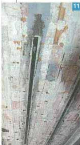
Foto 11. Applicazione sull'intradosso delle lamine CARBOPLATE, a interasse corrispondente alla nervatura del solaio.
