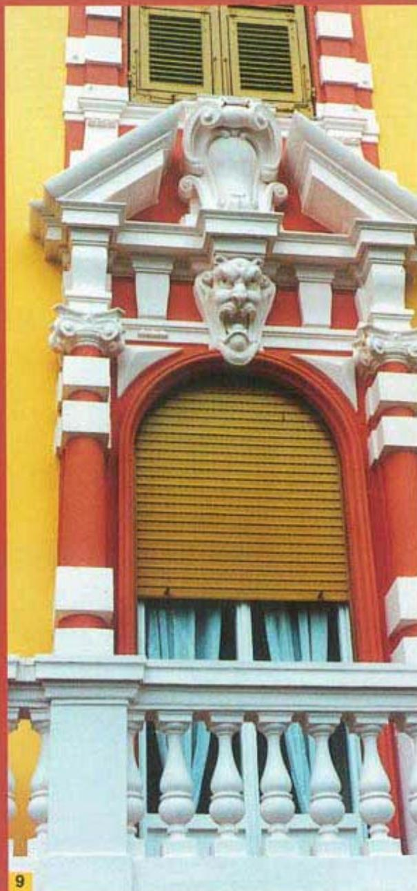
decorazioni - è stata impiegata la malta MAPE-ANTIQUE FC\*, prodotto con caratteristiche assolutamente identiche al precedente ma caratterizzato da una granulometria più fine. Un'ulteriore caratteristica essenziale delle malte MAPE-ANTIQUE è il colore chiaro, del tutto simile a quello delle antiche malte a base di calce idraulica.
