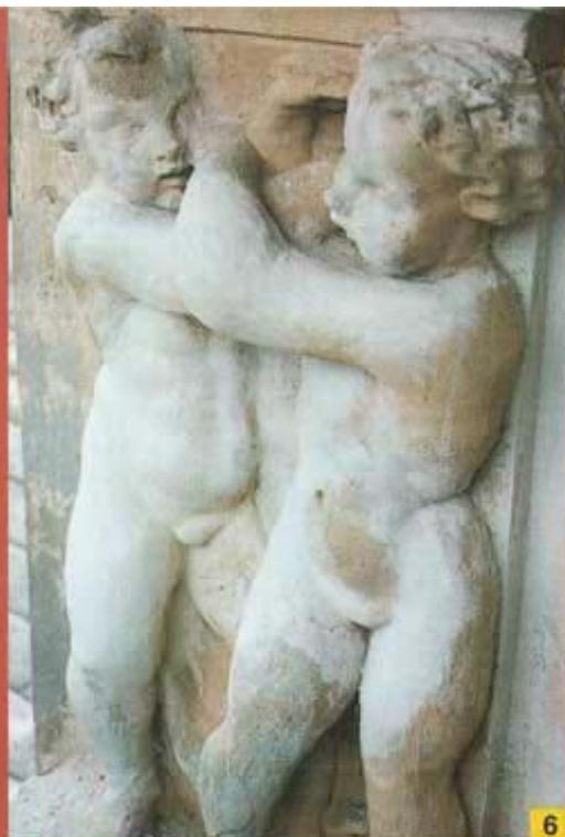
Foto 5. L'immagine mostra un esempio delle fessurazioni e del degrado sia delle superfici che degli amorini.
