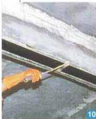
Foto 10. Applicazione - dopo opportuna preparazione delle superfici - della lamina pultrusa CARBOPLATE sull'intradosso di una trave.
