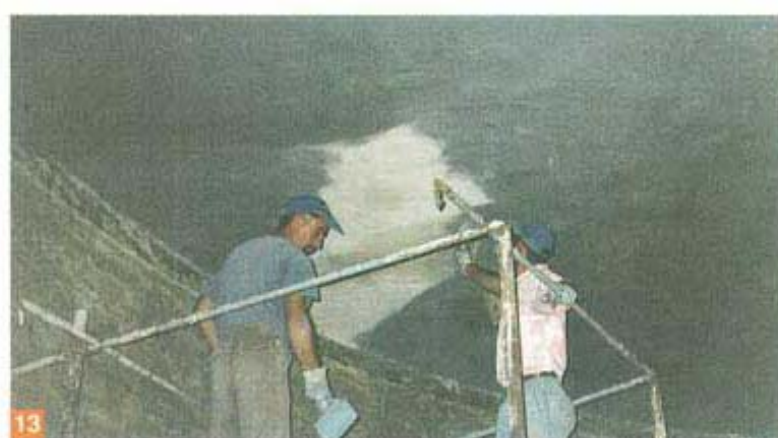
Foto 13. L'intradosso del serbatoio doveva essere trattato con un prodotto impermeabile sia all'acqua che al vapore, oltre a non essere tossico. È stata utilizzata così la vernice epossidica MAPECOAT I24.
