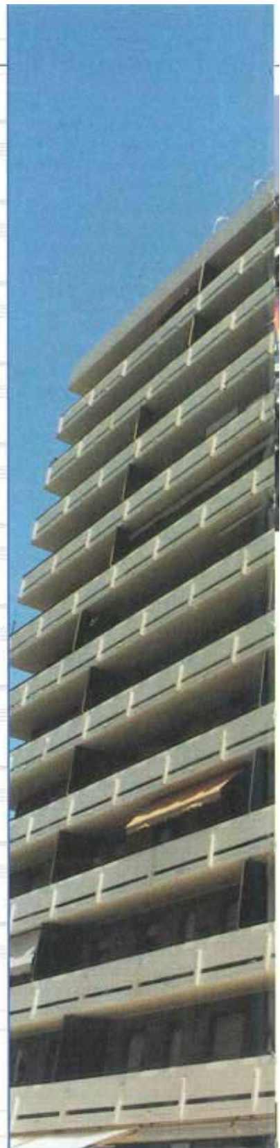
Foto 8 e 9. Prima di eseguire il trattamento di finitura, sono state effettuate delle prove in cantiere con prodotti diversi della gamma Mapei e anche della concorrenza. Nella prima foto, una fase della prova di misurazione della resistenza allo strappo e dello spessore del film della pittura finale eseguita su campioni diversi. Nella seconda foto, un campione trattato con una e due mani di ELASTOCOLOR.
