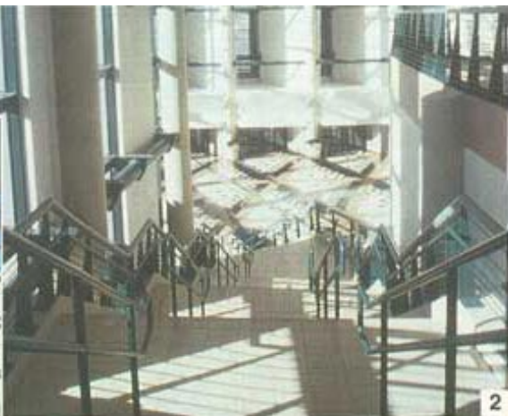
Foto 1 e 2. Per l'entrata principale e le scalinate sono state preferite le piastrelle in grado di garantire una buona resistenza all'usura di un traffico intenso. La posa è stata effettuata con ULTRA/CONTACT RS e la stuccatura delle fughe con ULTRA/COLOR .
