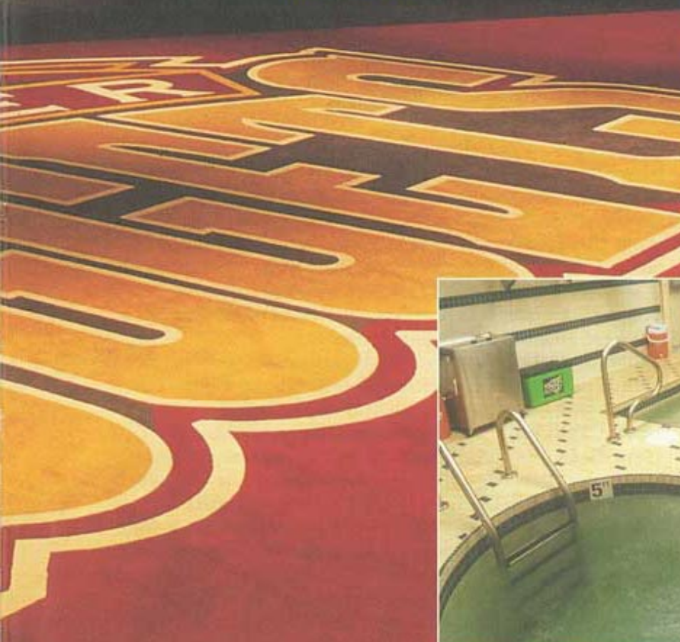
Foto 1 e 2. Per l'entrata principale e le scalinate sono state preferite le piastrelle in grado di garantire una buona resistenza all'usura di un traffico intenso. La posa è stata effettuata con ULTRA/CONTACT RS e la stuccatura delle fughe con ULTRA/COLOR .
