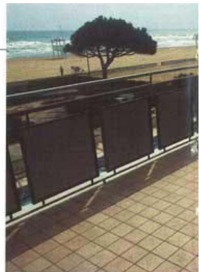
Foto 1. Dopo aver tolto le vecchie piastrelle e le guaine bituminose si procede alla stesura di MAPELASTIC.
