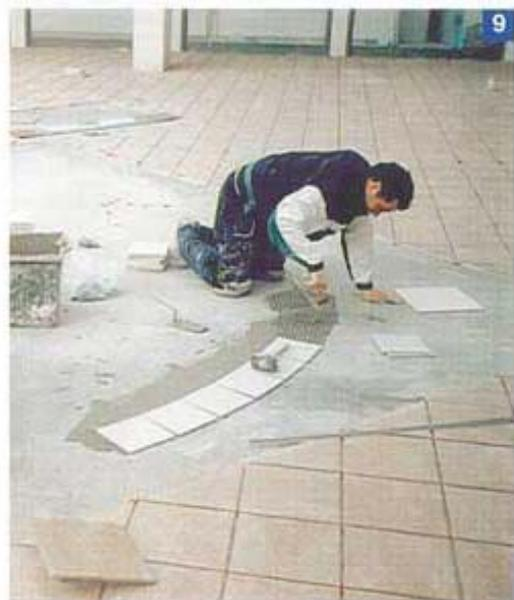
scivolamento verticale nullo. Per la stuccatura delle fughe è stato usato KERACOLOR FF\*. Per la posa delle piastrelle sui pavimenti all'interno della Residenza sono stati scelti gli stessi prodotti usati per il rivestimento delle pareti mentre, per quello
