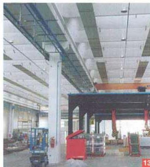
Il solaio tra piano fuori terra e piano interrato è stato progettato per sostenere due carrelli elevatori Cesab dal peso, a piena portata, di 185,4 KN; a questo carico se ne è aggiunto uno permanente di 50 KN. In più le travi che sostengono questo solaio, sono state calcolate per sostenere un carro-ponte da 50 KN per campata, necessario per la
