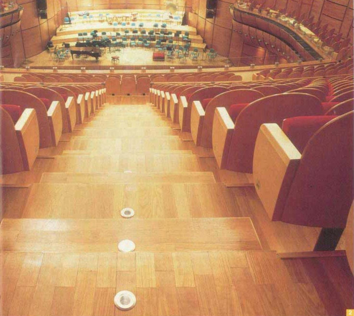
Foto 2. Le ali della galleria sovrastano la platea dell'Auditorium come nell'edificio originario. Il sottofondo dei pavimenti di questa parte dell'Auditorium è stato realizzato con TOPCEM e MAPECEM. Il pavimento poi è stato rivestito con parquet di rovere.
