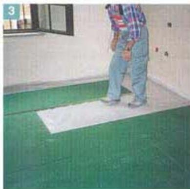
Foto 2. Tutti i massetti sono stati realizzati in cemento e polistirolo induriti superficialmente con il consolidante all'acqua Profas.
