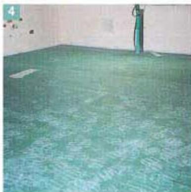
Foto 3. L'operazione di posa ha seguito una determinata successione che ha visto prima la stesura di due fogli di polietilene da 0,15 micron di spessore usati come schermo al vapore per proteggere il pavimento dall'umidità presente nei massetti in cemento e polistirolo.
