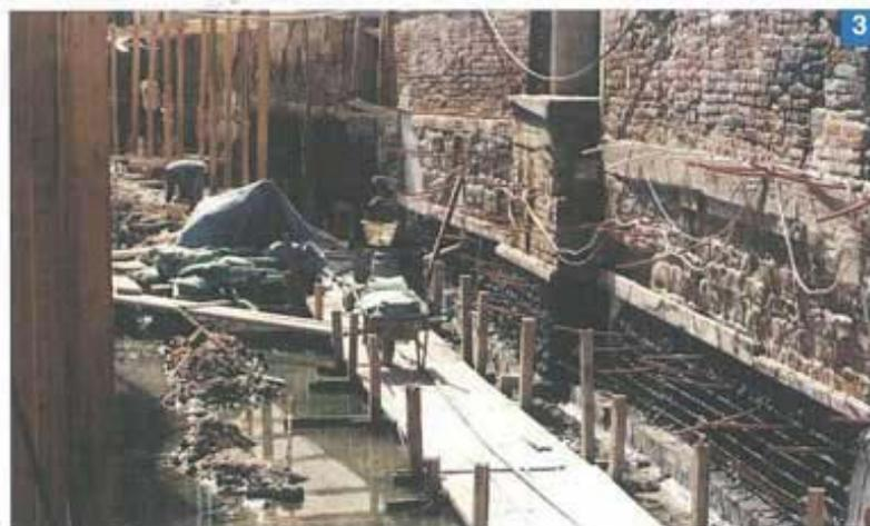
Foto 3. Il rio messo a secco. Nel muro di sponda viene iniettato Stabilcem, un legante cementizio espansivo superfluidico usato per riempire cavità e fessure, porosità interne in calcestruzzi e roccia. Il prodotto qui è stato usato nella versione HV (high viscosity) messa a punto appositamente per questo cantiere.
