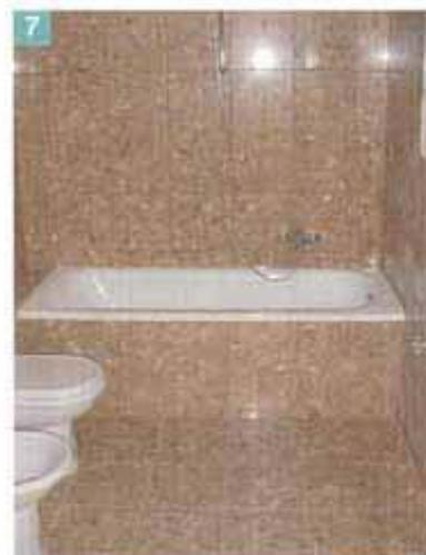
Foto 7. Le piastrelle ceramiche dei bagni sono state posate con l'adesivo ad alta adesione e scivolamento verticale nullo Keraflex. Per le fugature è stato utilizzato Keracolor FF.
