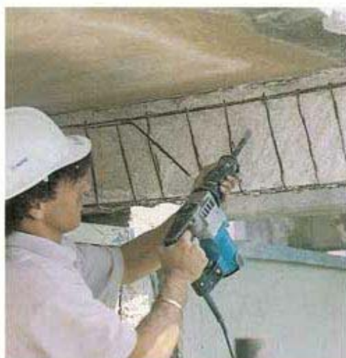
Demolizione di una mensola degradata
