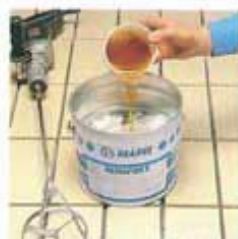
Miscelazione dei due componenti del KERAPOXY
