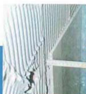
Posa a spessore di gres porcellanato a parete
