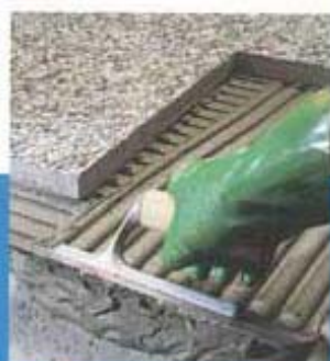
Posa di marmette con graniglie in rilievo all'esterno
