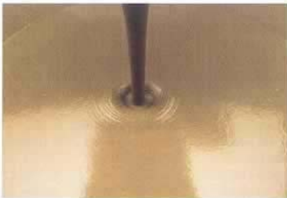
Particolare dell'applicazione di Ultraplan su pavimento in ceramica esistente previa applicazione di Mapeprim SP
