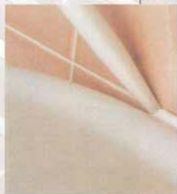
Sigillatura di sanitari.
