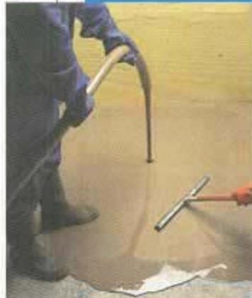
Applicazione di Ultraplan con pompa e successiva riapertura
