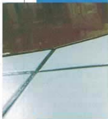
Particolare dell'applicazione di Ultraplan su pavimento in ceramica esistente previa applicazione di Mapeprim SP
