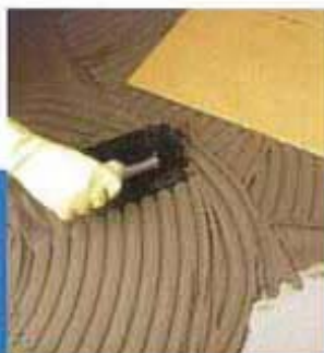
Stesura a spatola dentata di Elastorapid su massetto cementizio
