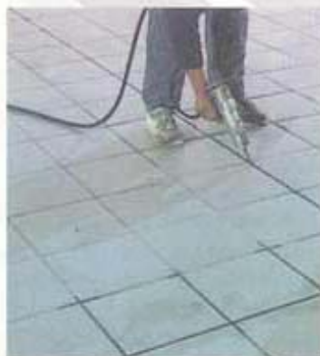
Sigillatura con Mapesil AC di un pavimento di ceramica.
