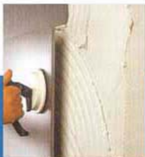
Posa di gres porcellanato di grande formato su facciate in calcestruzzo
