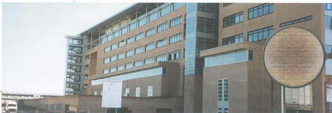
Foto 2. La facciata è stata realizzata con mattoni pieni assemblati con una scanalatura orizzontale che riprendono un motivo della tradizione costruttiva bolognese.
