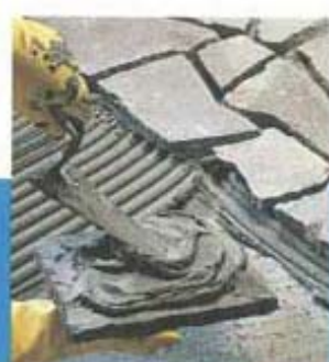
Posa di pietra a spacco in esterno con imburratura
