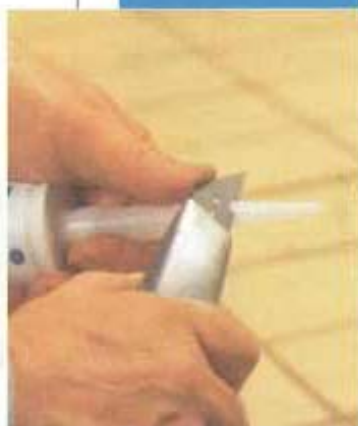
Tagliare l'ugello in base alle dimensioni del giunto
