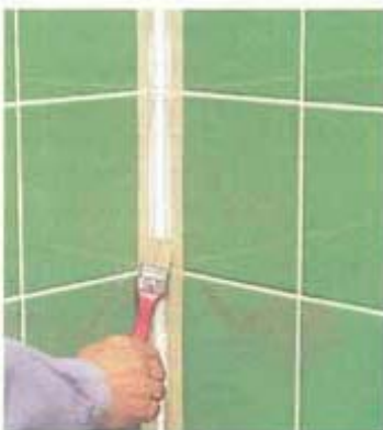
Lisciatura del giunto con acqua saponata a pennello.
