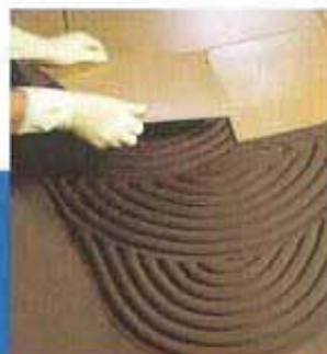
Posa di gres porcellanato su massetto impermeabilizzato con Mapelastic
