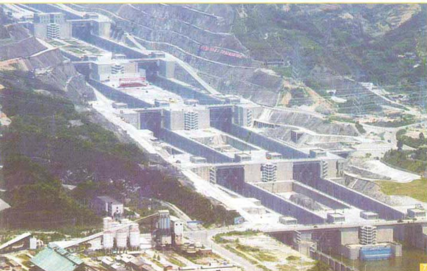
Foto 7. Un'altra immagine dei lavori in corso che mette in evidenza l'imponenza dell'opera.
