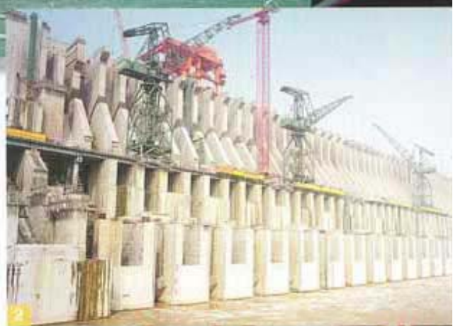
Foto 1 e 2. Una vista panoramica della diga e, in primo piano, un'immagine ravvicinata degli sfioratori.
