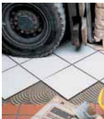
Posa di piastrelle in ceramica su pavimentazione industriale esistente in klinker
