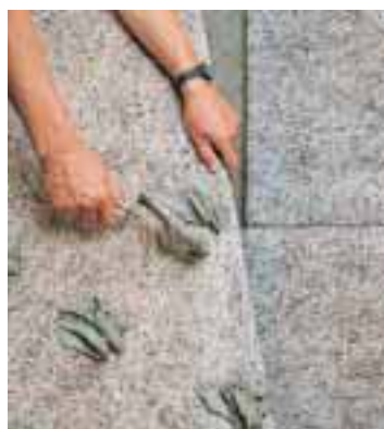
Posa di pannelli isolanti pesanti
