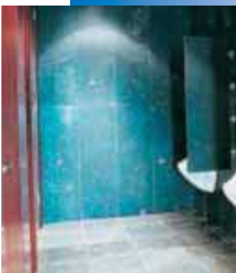
Esempio di posa con Keraquick a rivestimento - Bagno Casinò Feuchtwangen (Germania)
