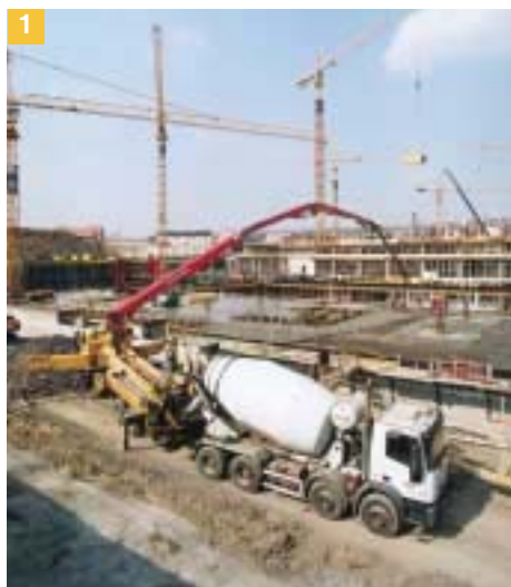
Foto 1, 2 e 3 Per la realizzazione della struttura in calcestruzzo sono state utilizzate 4 tonnellate di Mapefluid X404 e 4 di Dynamon SX.
