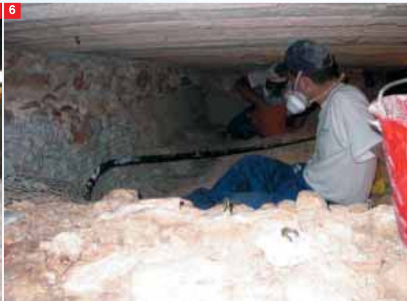
Foto 5. L'estradosso risultava irregolare e incoerente.
