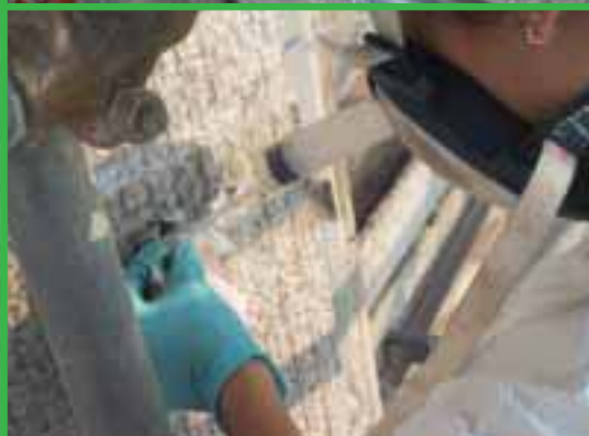
Foto 6. Iniezione di resina epossidica Epojjet LV. Realizzazione dei fori di iniezione (diametro dei fori: 10mm; profondità: 30 mm - in modo da intercettare la soluzione di continuità tra malta di posa e calcestruzzo di regolarizzazione). Pulizia dei fori con aria compressa. Posizionamento all'interno dei fori del tubetto d'iniezione e del tubetto spia. Iniezione di resina epossidica.
