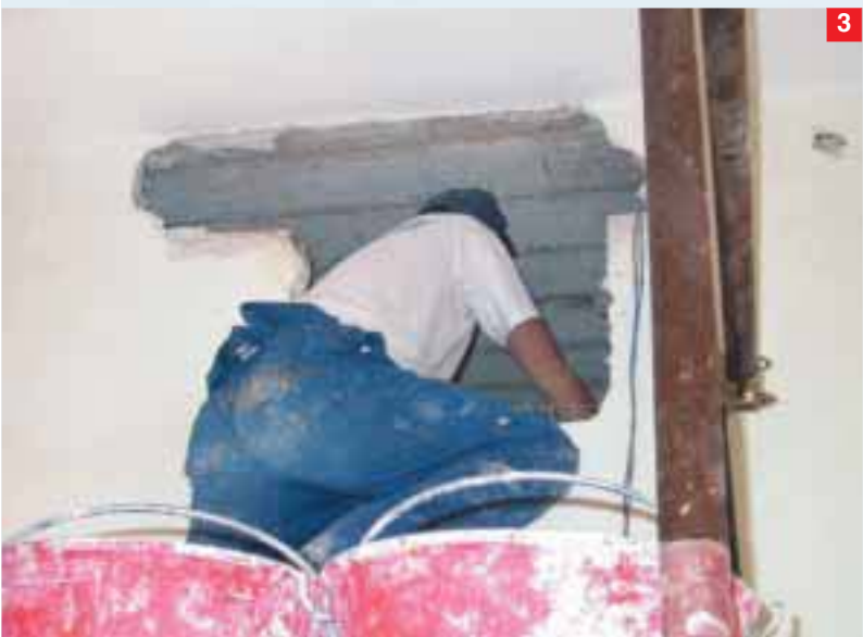
Foto 3 e 4. L'estradosso della volta non aveva accessi diretti e lo spazio tra l'estradosso e la copertura era di solo 80 cm.
