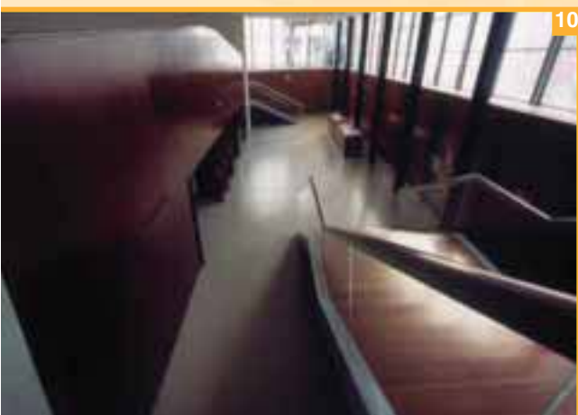
Foto 10. Posa di marmo di Carrara effettuato con Keraquick bianco.
