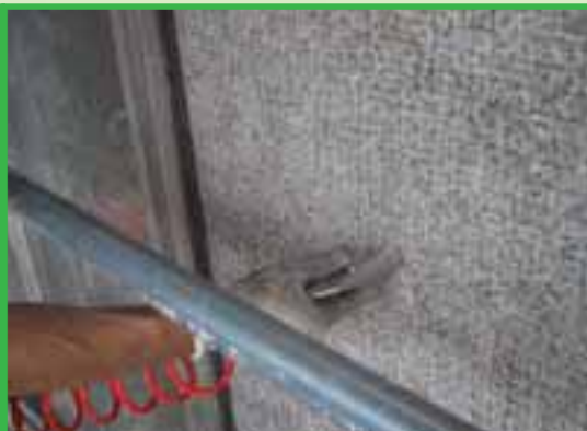
Foto 6. Iniezione di resina epossidica Epojjet LV. Realizzazione dei fori di iniezione (diametro dei fori: 10mm; profondità: 30 mm - in modo da intercettare la soluzione di continuità tra malta di posa e calcestruzzo di regolarizzazione). Pulizia dei fori con aria compressa. Posizionamento all'interno dei fori del tubetto d'iniezione e del tubetto spia. Iniezione di resina epossidica.
