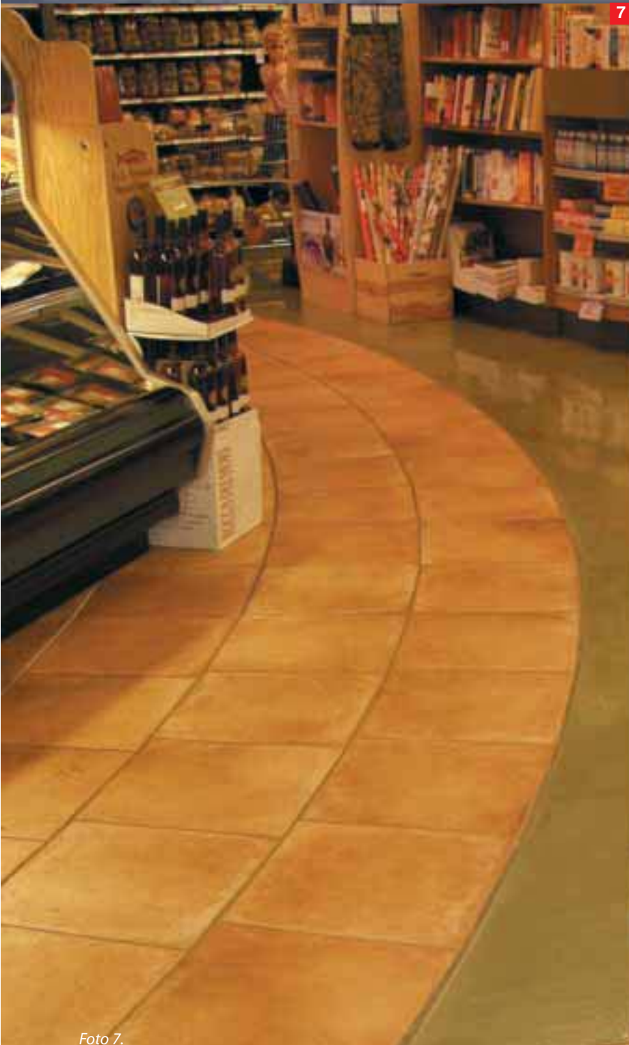
Foto 7. Per movimentare ulteriormente il pavimento e definire i settori sono stati utilizzati anche altri materiali affiancati a Ultratop applicato in varie gradazioni cromatiche.
