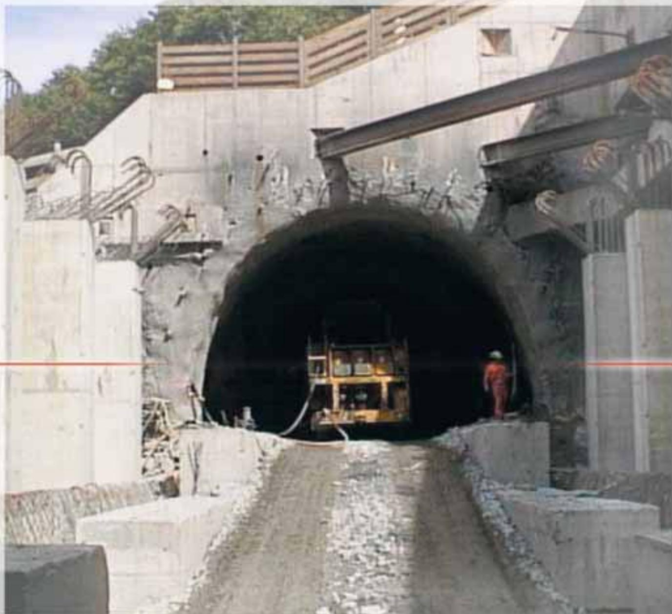
(a 24 ore  $R_{ck}=15-20 \text{ N/mm}^2$ ), mentre il secondo, MAPEQUICK AF 2000, grazie al tempo di presa sensibilmente più rapido, permette l'autosostentamento del calcestruzzo proiettato anche in presenza di acque percolanti.
