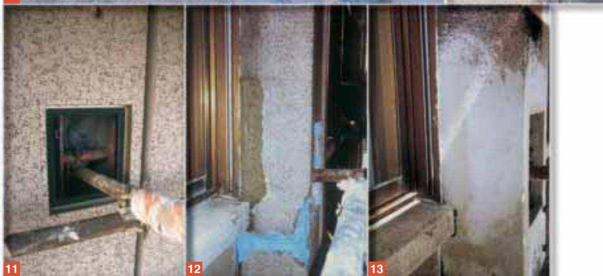
lavori. Successivamente è stata verificata la consistenza di tutti i pannelli di facciata mediante "battitura", quindi le parti in fase di distacco o ammalorate sono state demolite fino al raggiungimento degli strati coerenti e sani dell'impasto cementizio. Durante la demolizione sono stati rimossi anche i ganci per la movimentazione dei pannelli, sono stati asportati i giunti e le sigillature e completamente messi a nudo i ferri
