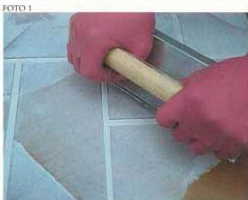
FOTO 1 Esempio di applicazione in condizioni di buona lavorabilità.
