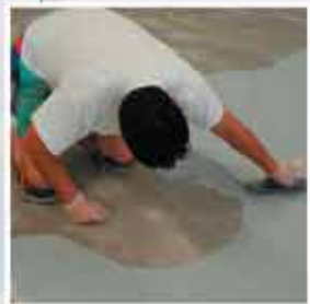
Fase di stesura dell'autolivellante Mapefloor I 300 SL.
