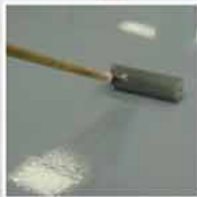
Sul rivestimento appena steso si esegue un passaggio del rullo frangibolle per favorire la fuoriuscita dell'aria inglobata durante la miscelazione dei materiali.
