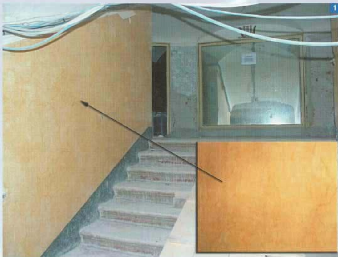
Foto 1. Interno del Teatro alla Scala di Milano: nel riquadro in basso a destra è riportato un particolare del marmorino del Piermarini, l'originaria finitura delle pareti che è stata ricoperta da più strati di pittura.
