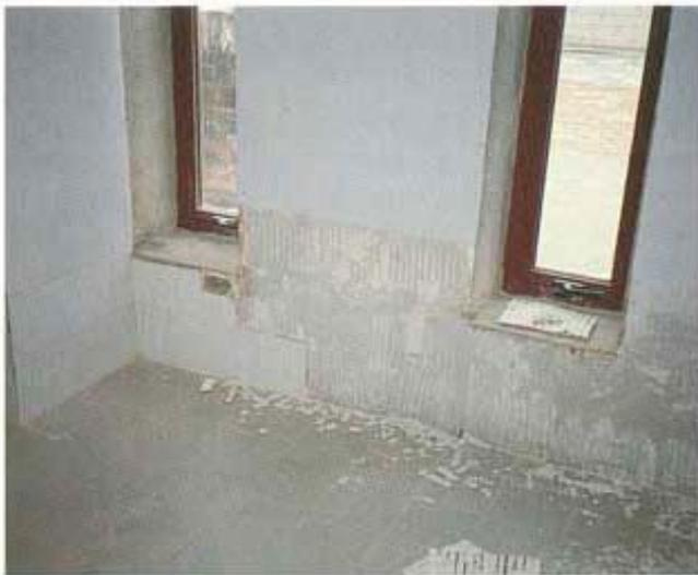
Sopra, distacco di piastrelle da una parete in gesso a causa della risalita di umidità dal letto di malta usato per la posa del pavimento ceramico.
