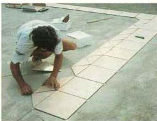
Le imperfezioni dei massetti o delle strutture sono state corrette con il rasante NIVORAPID a base di leganti a presa e asciugamento rapidi in modo da permettere la quasi immediata posa del rivestimento. Alcune riprese di getto che hanno presentato delle fessurazioni dovute alle condizioni estreme di lavoro (si è lavorato in
