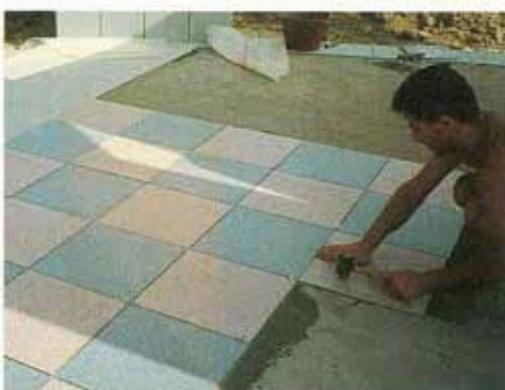
organizzazione e l'uso di prodotti particolari e tecnologicamente innovativi hanno permesso la posa dei più svariati tipi di pavimenti e rivestimenti ceramici. I lavori sono iniziati il 29 giugno con la delimitazione dell'area interessata e il tracciamento dei viali e delle parti da pavimentare con la posa dei cordoli. Dopo 5 giorni la zona era pronta per la stesura del massetto.
