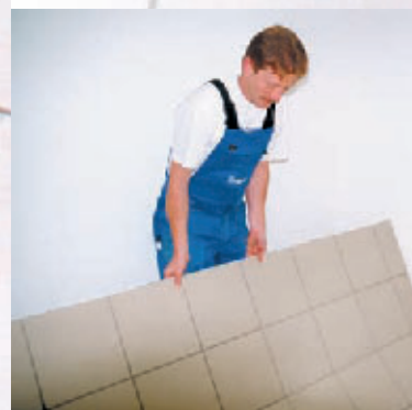
Rimozione di pavimentazione ceramica posata con Mapetex System.
