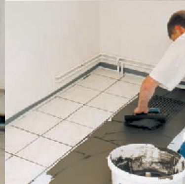
Posa delle piastrelle di ceramica con Keraquick.
