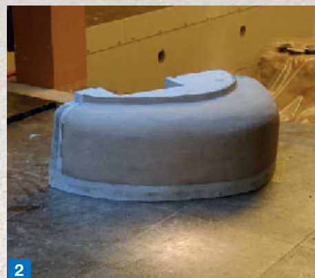
Foto 4. Colonna interamente ricoperta di polistirolo rasata con Planipatch + Latex Plus.
