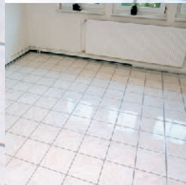
Pavimento finito facilmente removibile grazie a Mapetex System.
