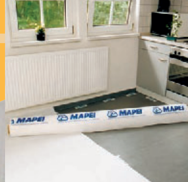
Fissaggio di Mapetex su Mapetex Strip.
