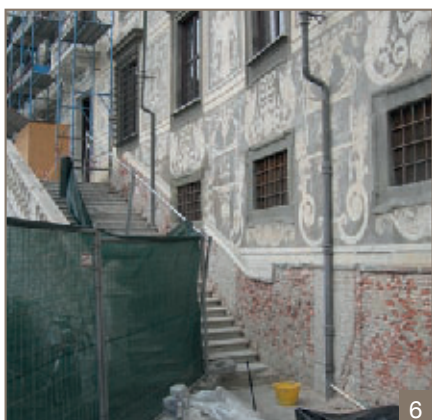
Foto 6. Rimozione dell'intonaco degradato nella parte inferiore della facciata.
