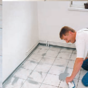
Stuccatura del rivestimento con Ultracolor Plus.
